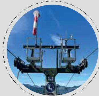
Windmessgerät auf einer Stütze am Kufsteiner Kaiserlift.
