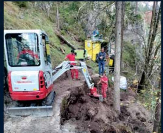
Freilegung schadhafter Stützmauern für die Sanierung.
